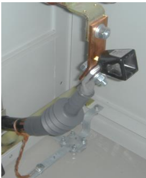
Slika 19: Ustrezen spoj SN kabla - notranja vgradnja
