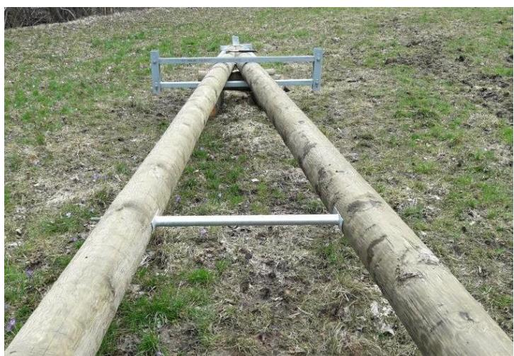
Slika 2: Primer sodobnejše vgradnje prečke v kovinski izvedbi
