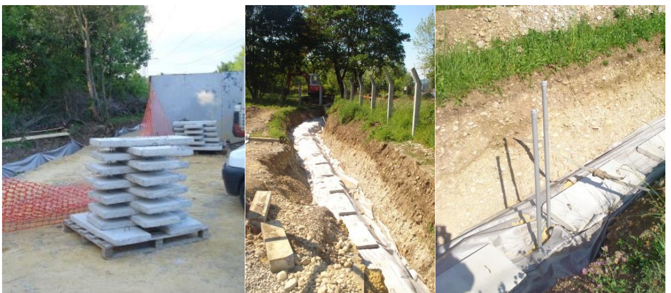
Slika 25: Betonske zaščitne plošče in merilno mesto
