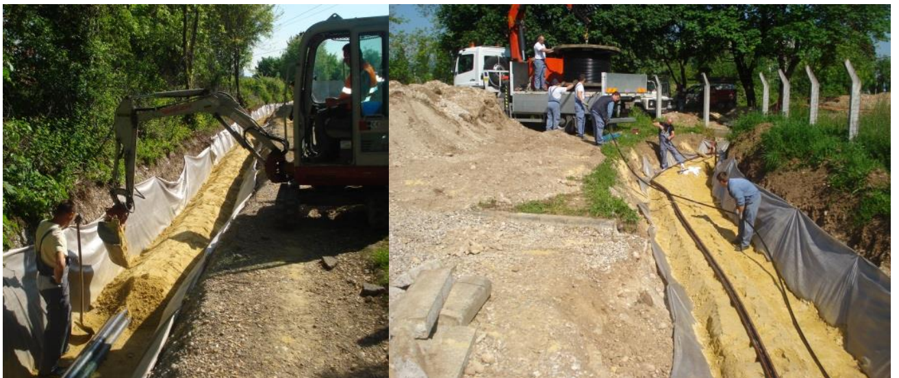
Slika 24: Strojni zasip in polaganje PEHD dvojčka in ozemljilnega kabla
