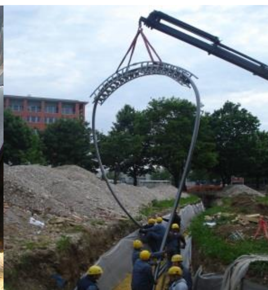
Slika 22: Valjčna uvodnica pri prehodu v cev kabelske kanalizacije in valjčna proga za vleko kabla
