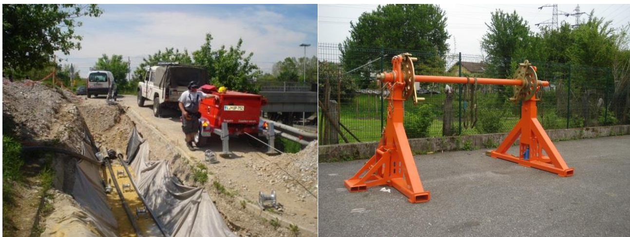
Slika 26: Vlečna vitla in stojke za kabelski boben
