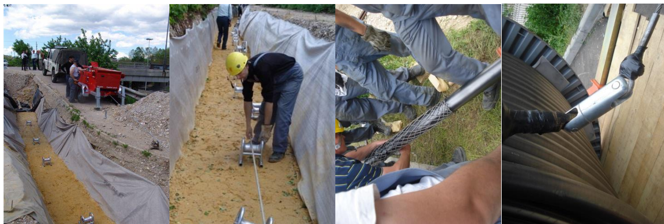
Slika 19: Priprava na vleko kabla (razporejanje valjčkov, vlečne vrvi, natikanje vlečene nogavice, gibljivi vezni člen)
