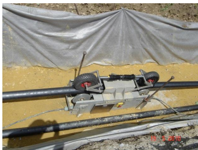
Slika 21: Potisno vlečni stroj s hidravličnim pogonskim agregatom
