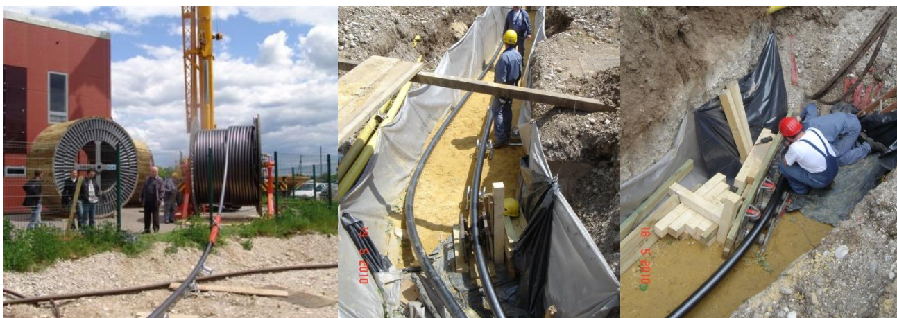
Slika 20: Vleka kabla (postavitev bobna, vlek v krivini, uvlek v kabelsko kanalizacijo pri križanju ceste)
