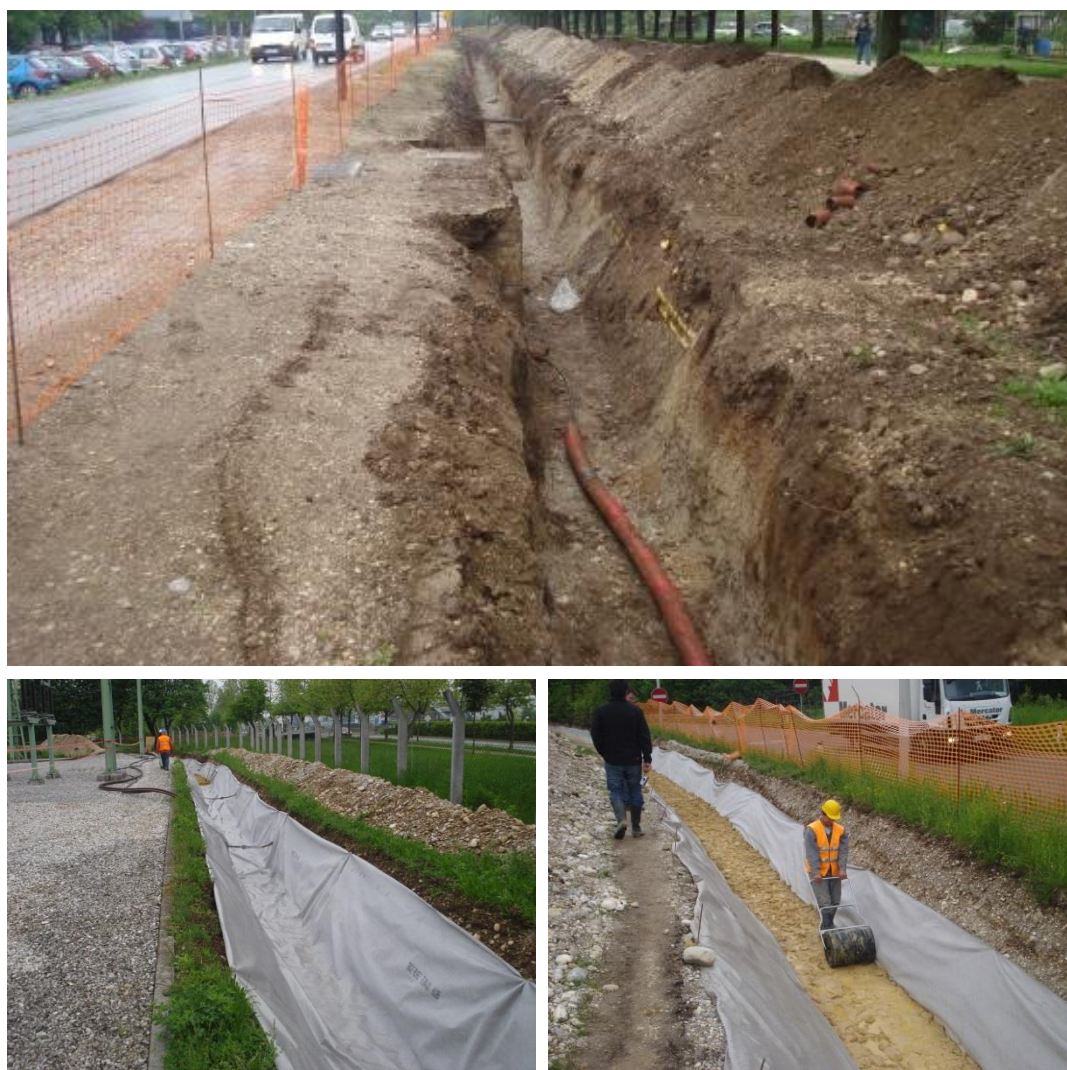
Slika 18: Priprava kablanskega jarka (izkop, polaganje geotekstila, priprava posteljice)
