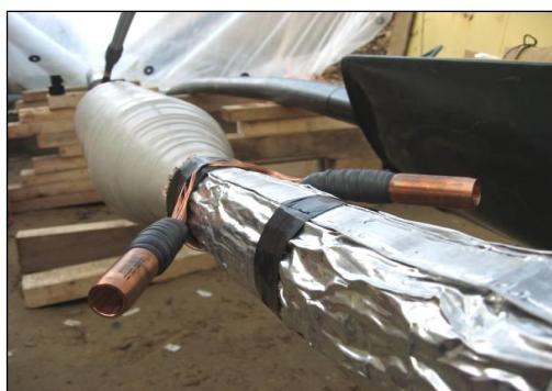
Slika 36: Primer izdelave kableske spojke s prepletanjem zaslonov
