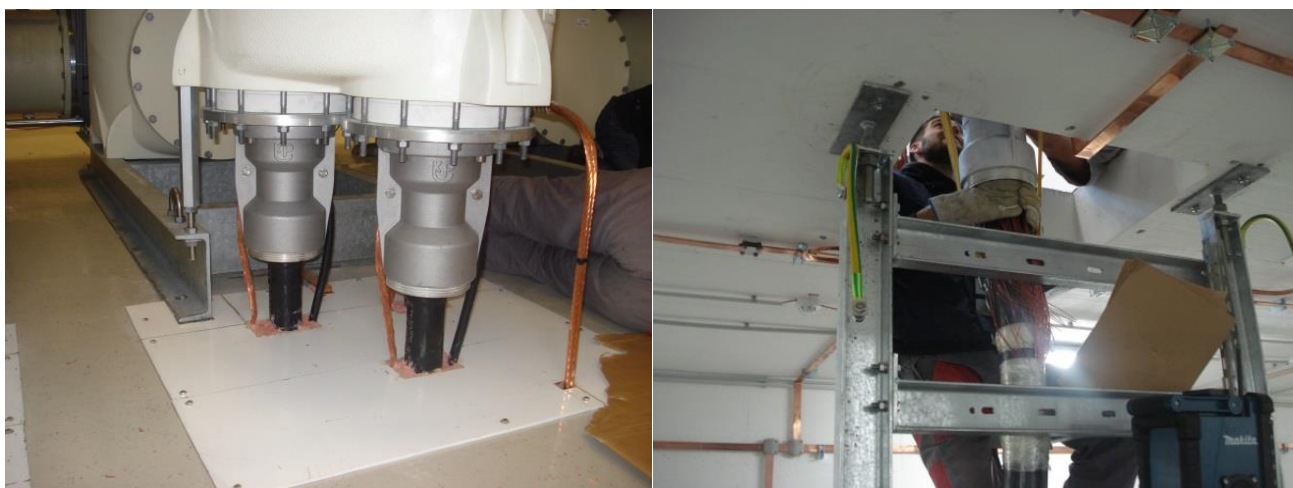
Slika 27: Izvedba kabelskih končnikov v GIS stikališče
