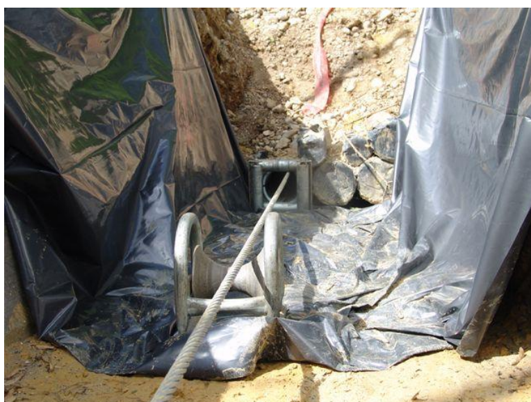
Slika 22: Valjčna uvodnica pri prehodu v cev kabelske kanalizacije in valjčna proga za vleko kabla
