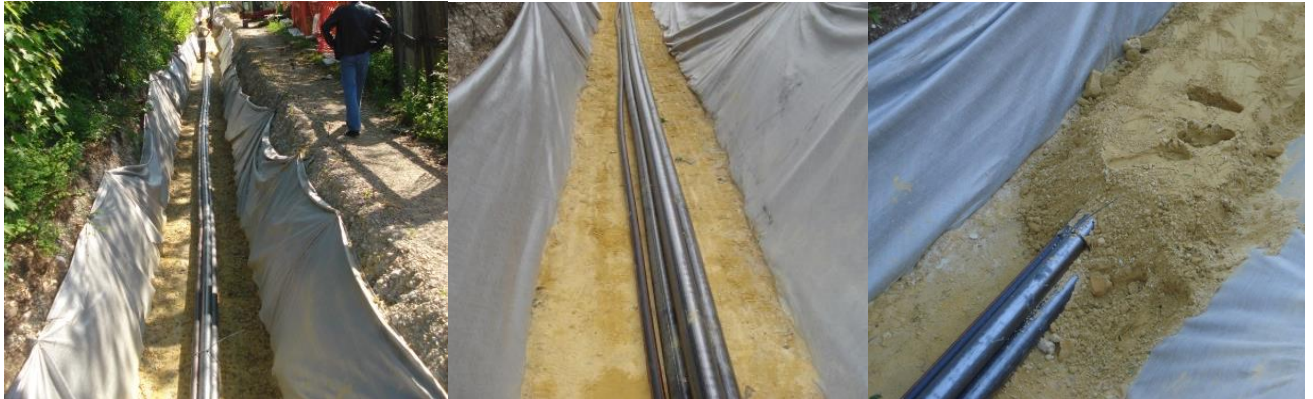
Slika 23: Zasip kabla
