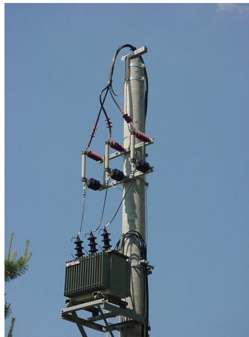
Slika 18: Izvedba priklopa na ločilniku (levo) in Izvedba priklopa na stebrni postaji (desno)
