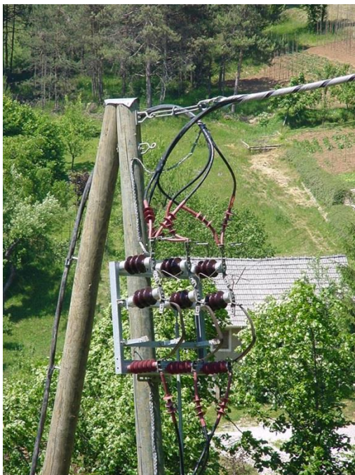
Slika 18: Izvedba priklopa na ločilniku (levo) in Izvedba priklopa na stebrni postaji (desno)
