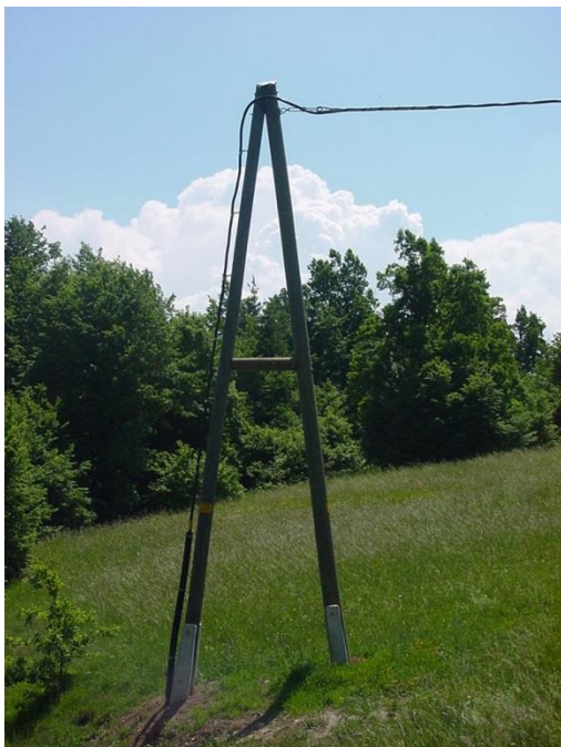
Slika 19: Prehod v zemljo (levo) in Zaščita kabla ob prehodu v zemljo (desno)
