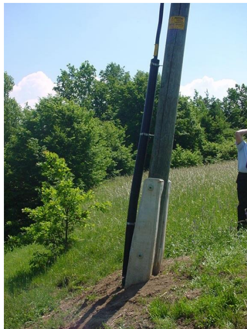
Slika 19: Prehod v zemljo (levo) in Zaščita kabla ob prehodu v zemljo (desno)
