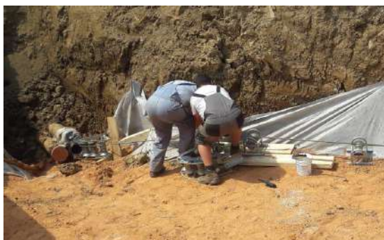
Slika 20: Valjčna proga in prikaz njene uporabe na ostrih krivinah
