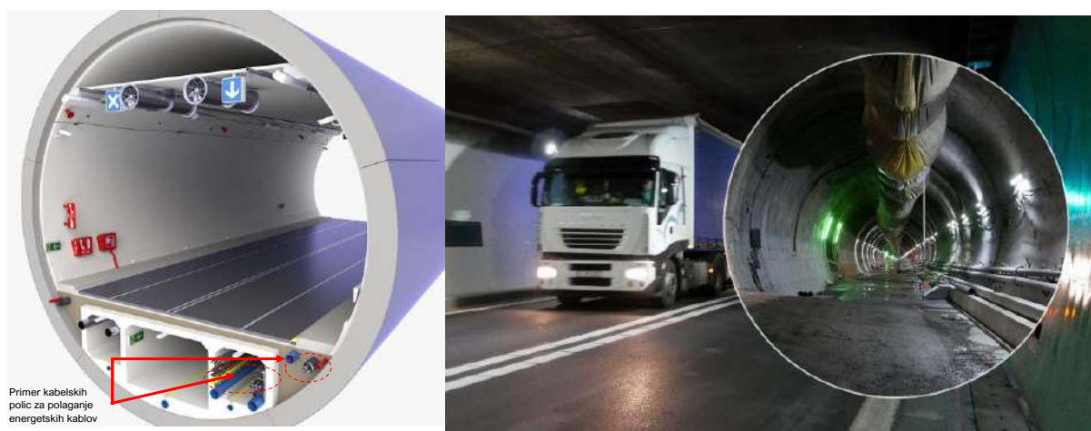
Slika 14: Polaganje kablov v cestnih predorih
