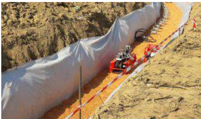
Slika 23: Uporaba valjčkov in vesp pri polaganju SN kablov
