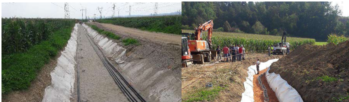
Slika 68: Uporaba valjčkov za polaganje VN kablov
