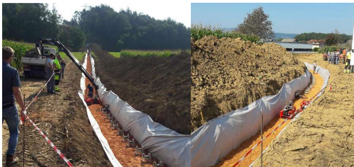
Slika 69: Uporaba navadnih in motorno gnanih valjev (vesp) pri polaganju kablov
