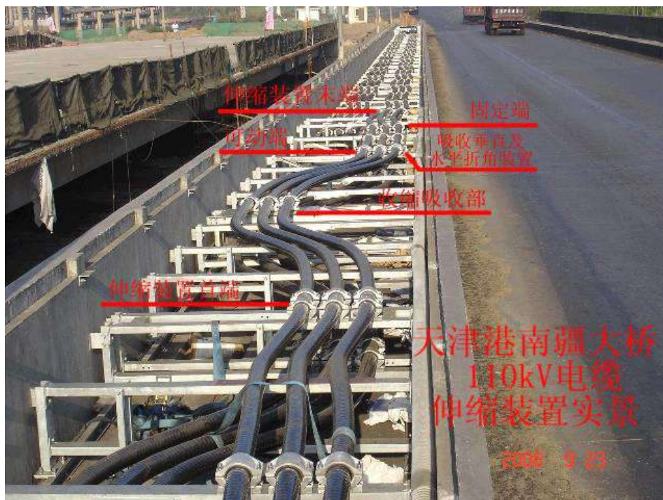
Slika 61: Vijugasto polaganje 110 kV kablov na mostu Tianjin Nanjiang Bridge, Kitajska
