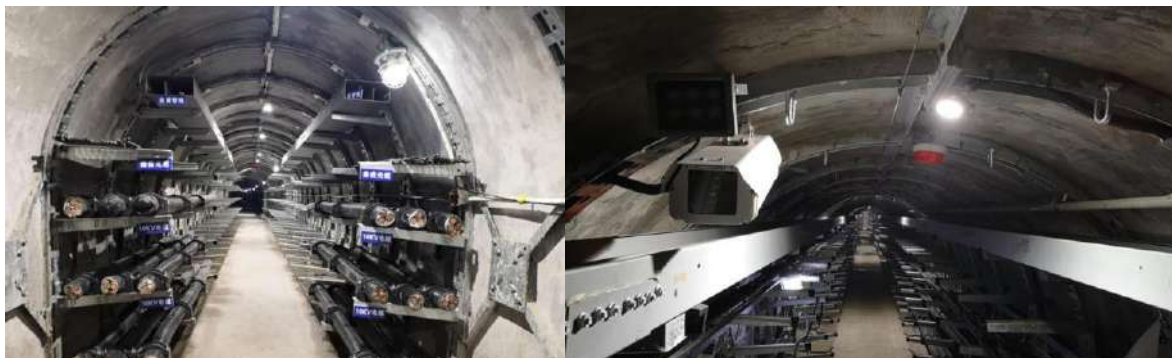
Slika 13: Polaganje kablov v kabelskih predorih
