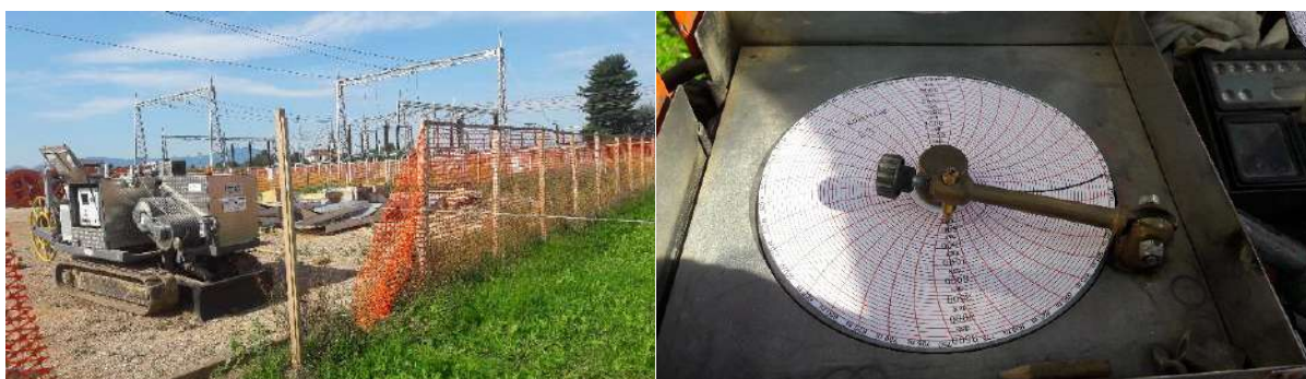
Slika 65: Strojno vlečenje kabla skozi kabsko kanalizacijo in beleženje vlečne sile dinamometrom
