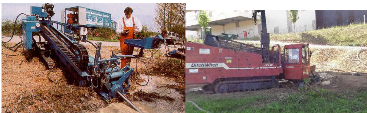
Slika 64: Izdelava kabske kanalizacije s podvrtavanjem
