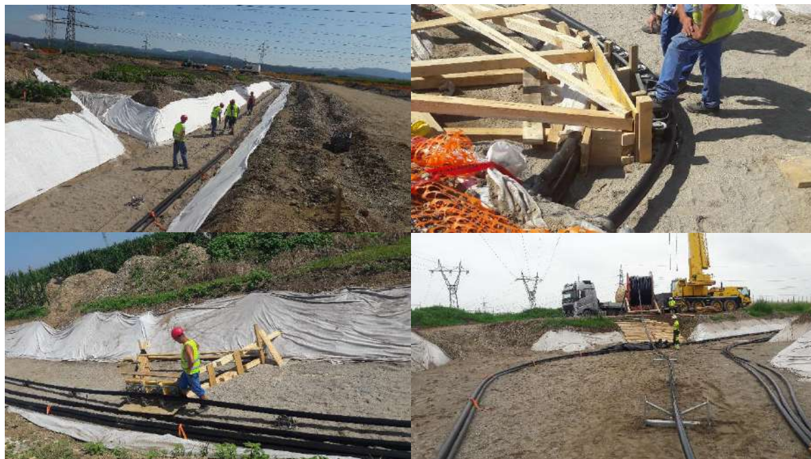
Slika 63: Polaganje VN kablov direktno v kabelski jarek
