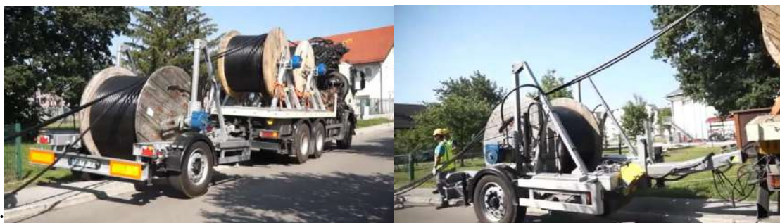
Slika 15: Sočasno polaganja vseh treh faz SN kablov s kamiona in dodatne prikolice
