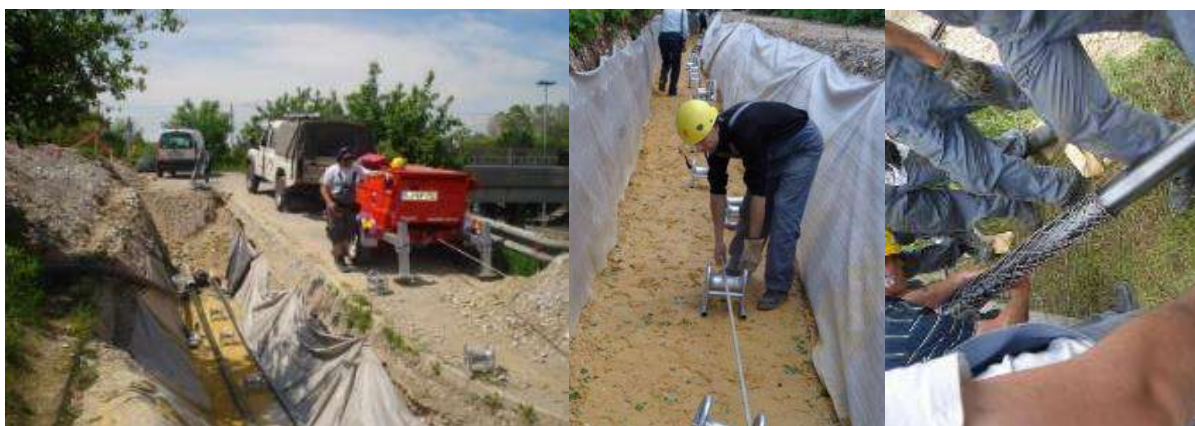
Slika 17: Prikaz opreme za strojno polaganje kabla
