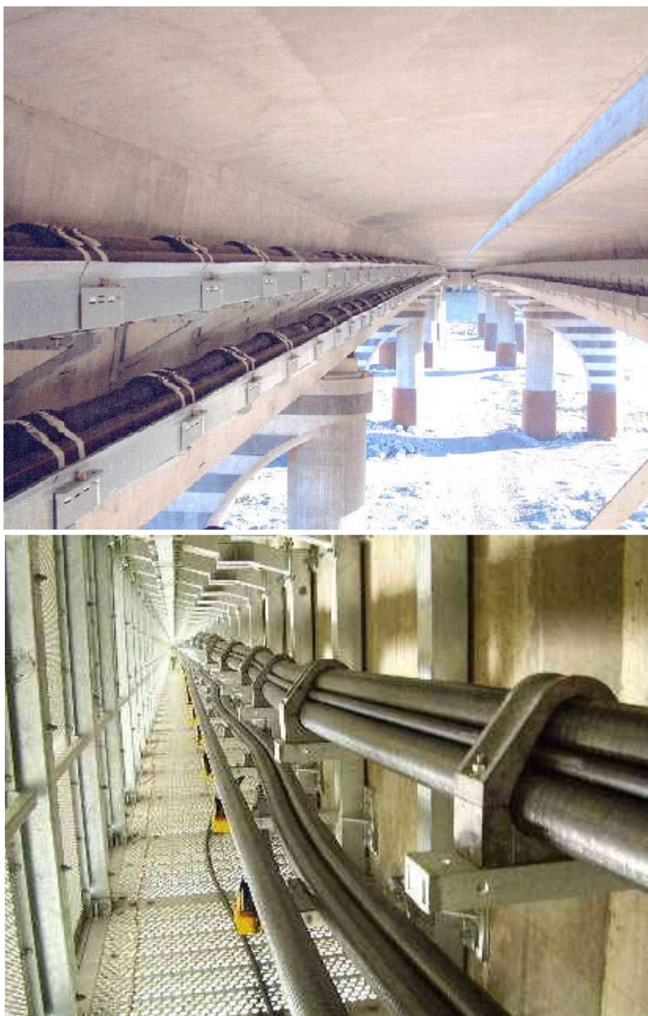
Slika 62: Primer namestitve 110 kV kablov na betonskem mostu v Franciji
