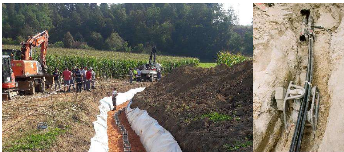
Slika 21: Uporaba valjčkov za polaganje SN kablov
