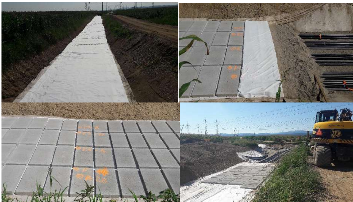
Slika 67: Zasipavanje kablov in namestitvev zaščit ter markerjev
