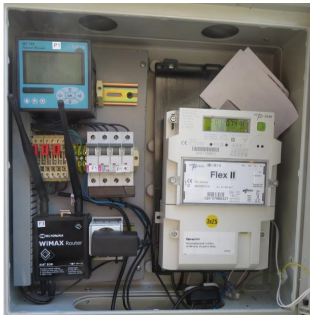
Slika 3: Nameščena oprema v priključno-merilni omarici.
