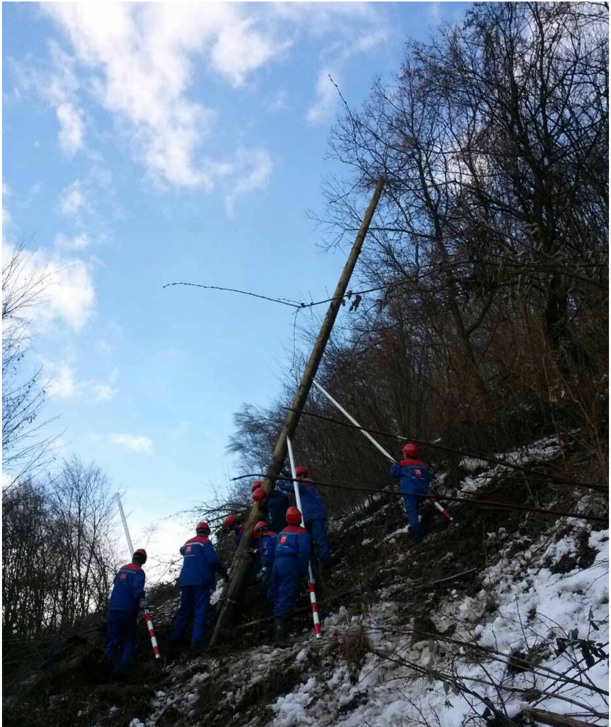
Fotografija 4: Postavljanje oporišča za poškodovan sredjenapetostni daljnovod na težko dostopnem območju Kamniške grabe. Posnetek: mag. Boris Sovič, Elektro Maribor.
