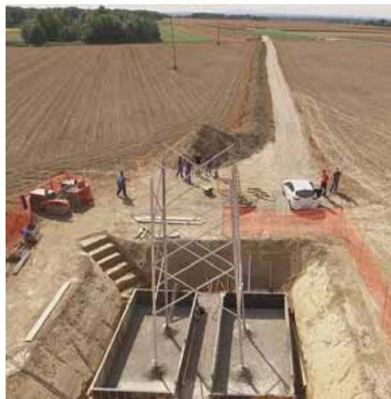
Slika 75: Gradnja visokonapetostnega daljnovoda na območju Goriškega. Posneto iz drona, arhiv Elektro Maribor.
