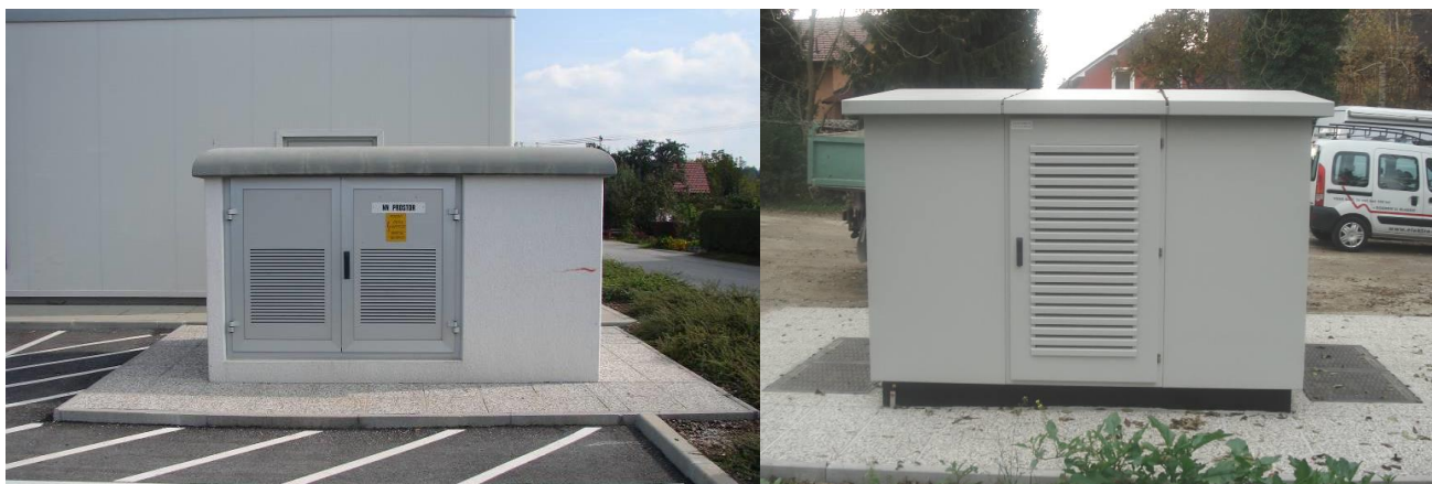
Slika 2: Primeri izvedbe KTP: betonska (levo) in pločevinasta (desno)
