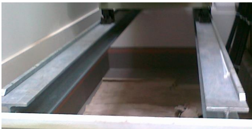
Slika 11: Zgled oljnega lovilca z nosilcem transformatorja
