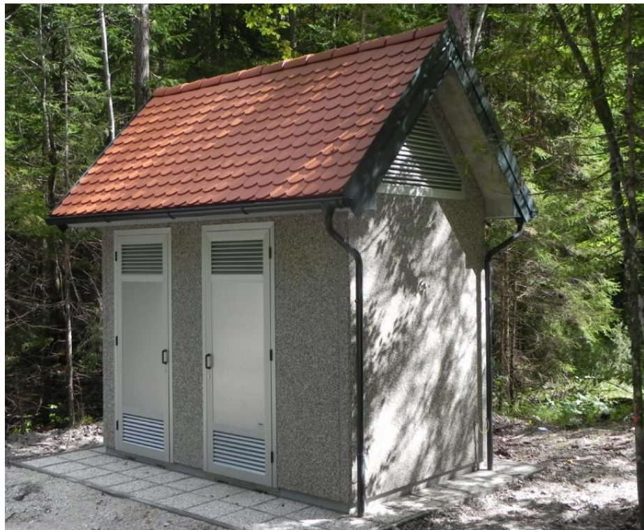
Slika 39: Primer postavitve MTP 250/45
