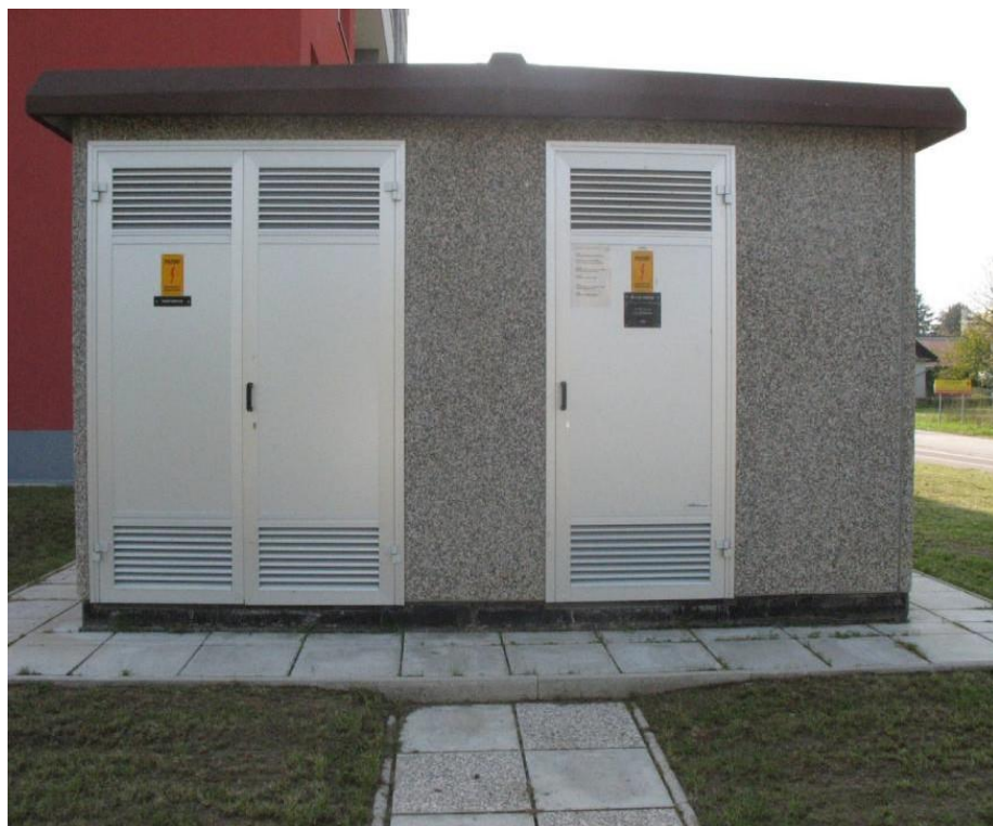
Slika 40: Primer postavitve MTP 630/0
