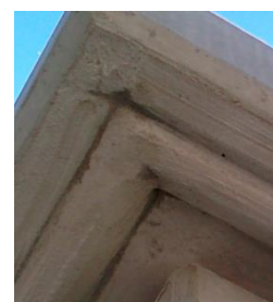
Slika 17: Primer ravne strehe iz enega dela (levo) in izvedba odkapnika strehe (pogled od spodaj)
