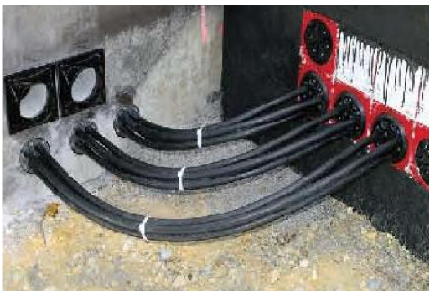
Slika 6: Vgradnja kabelskih uvodnic
