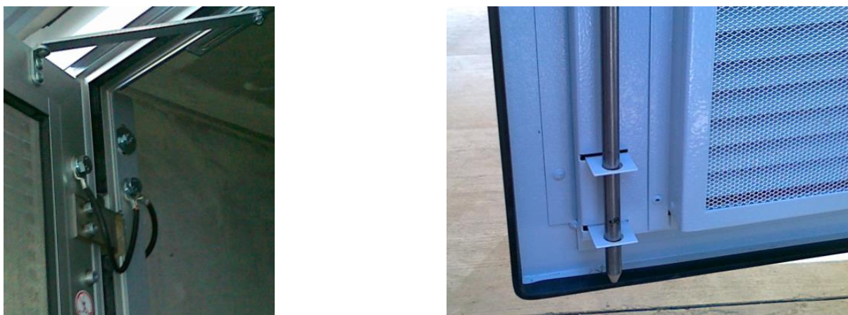
Slika 22: Zaskočni mehanizem vrat (levo) in del zapiralnega sistema (desno)
