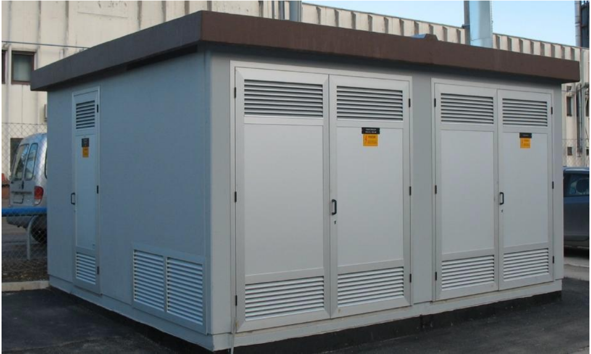
Slika 43: Primer postavitve MTP 2x 1000/0
