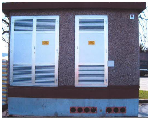
Slika 13: Pozicija odprtine za agregat ob vratih in stenski element za agregatni kabel- servisna uvodnica (zunanji del)
