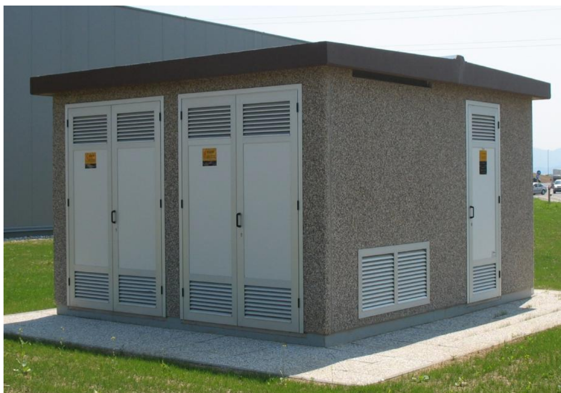
Slika 42: Primer postavitve MTP 2x630/0
