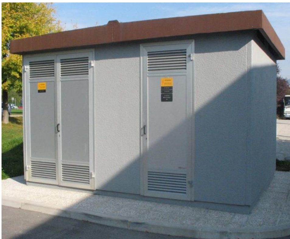
Slika 41: Primer postavitve MTP 630/0
