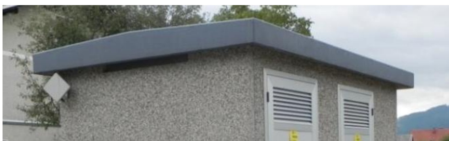
Slika 17: Primer ravne strehe iz enega dela (levo) in izvedba odkapnika strehe (pogled od spodaj)
