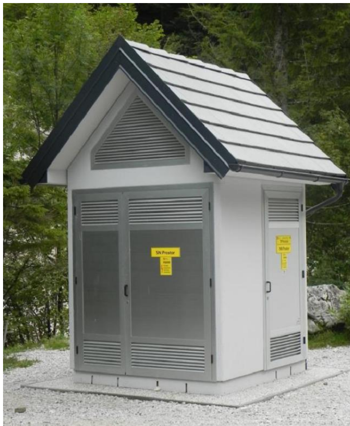
Slika 37: Primer postavitve MTP 250/45
